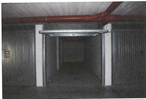
AUTORIMESSA N.28B/C SUB.80
