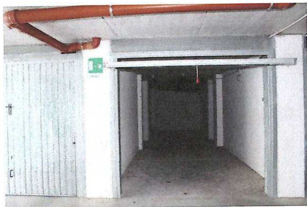
AUTORIMESSA N.7A/D SUB.34
