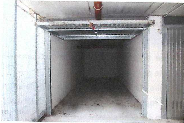
AUTORIMESSA N.31A/D SUB.58
