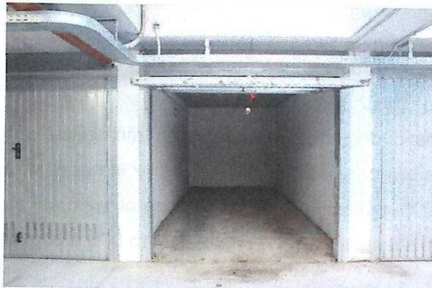
AUTORIMESSA N.20A/D SUB.47
