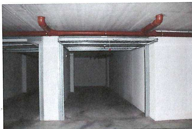
AUTORIMESSA N.4A/D SUB.133
